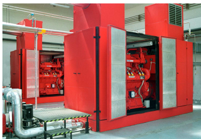
Kogenerační jednotky MOTORGAS pracují v 74 bioplynových instalacích s celkovým výkonem přes 17 MWe.
